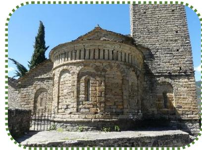
Con una altura próxima a los diecisiete metros, fue edificada sobre la capilla lateral norte. De planta cuadrada, se compone en sus cuatro caras por ventanas ajimezadas de tres arcos de falsa herradura que le otorgan un estilo muy personal.
